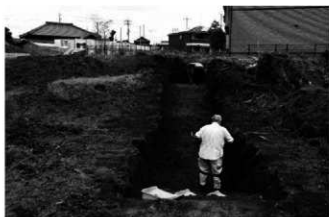
2T 土壘中央掘り下げ状況
