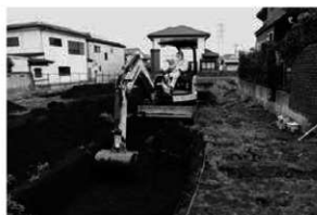
小板橋遺跡 地点トレンチ掘削状況
