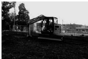
平沢遺跡 f 地点トレンチ掘削状況
