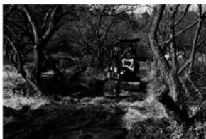
勝田大作遺跡 g 地点トレンチ掘削状況
