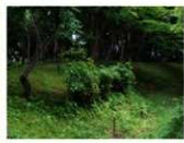
2 本曲輪土塁 幅10m、残存高1.5mを測る。往時は2~3m程の高さがあった。
