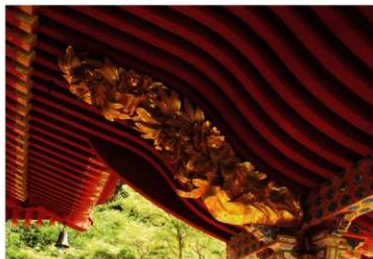
手扶(たばさみ：向拝柱の内側に、屋根の重木彫配に沿って入れられた化粧板)には、金色の八重木牡丹と葉が立体的に浮き彫りされている。
