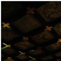
格天井とは太い角材を井桁状に組んだ天井で、格式の高い建物に用いられる。
