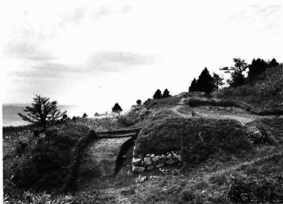
(2) 弥高寺跡第2次調査石垣SA01 (東から)
