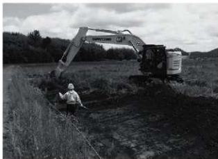
写真1 山ノ下遺跡 表土剥ぎ風景
