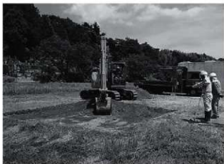
写真3 平ノ前遺跡P3区 表土剥ぎ風景
