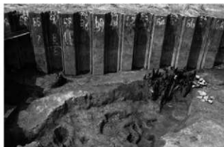
4 13溝・15溝完掘状況（南西から）
