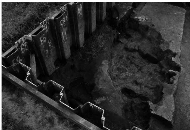
4 8溝杭列群取り上げ状況（西から）
