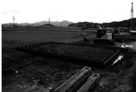
1 調査前近景 (南西から)
