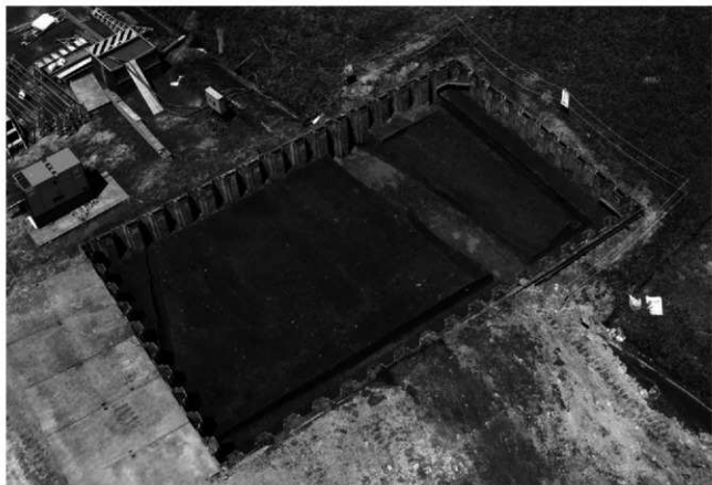
1 第1遺構面完掘状況（南東から）
