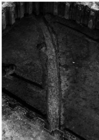
1 9溝完掘状況（北東から）
