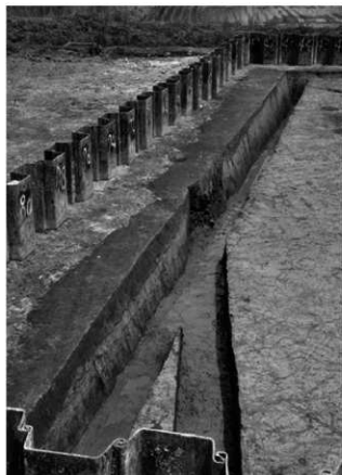
2 西壁断面(南から)
