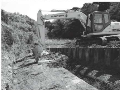
3 機械掘削状況（北西から）
