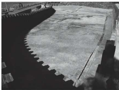
2 完掘状況1(南西から)
