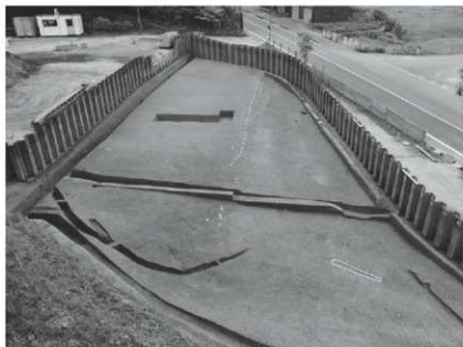
3 11面全景 (北東から)
