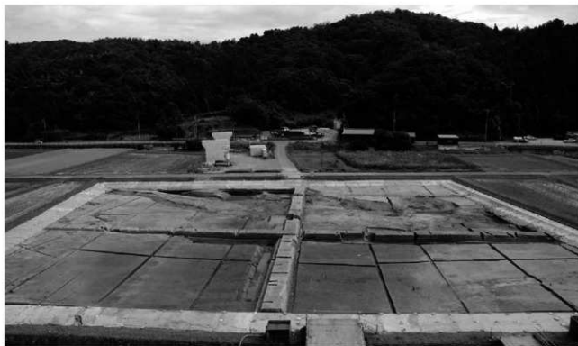
2 6面完掘状況 (西から)
