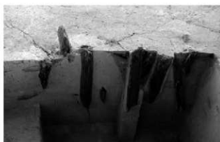
3 46 杭列断割状況(南東から)
