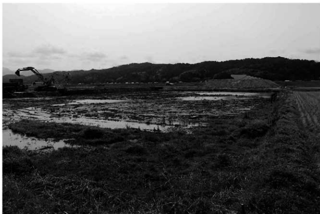
1 調査前風景(北東から)
