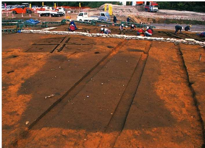
竪穴建物跡 37・38・39号検出状況 (西側から撮影, 左奥は 36号)
