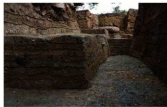
写真54 金堂基壇版築 (第4次南から)
