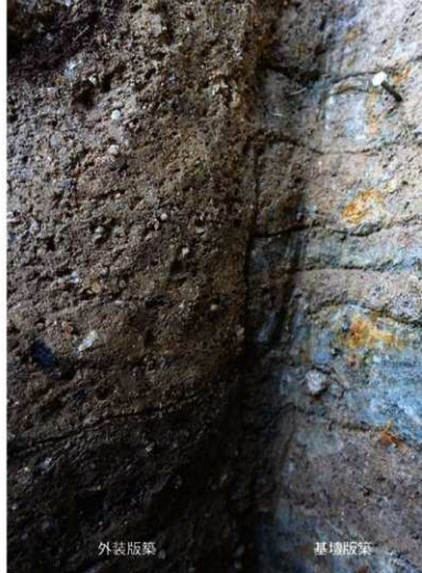
写真66 外装改修による基礎版築の切断部(第11次北東から)
