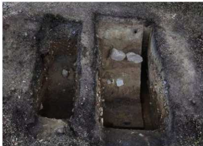
写真65 北面の基礎外表と断ち割り(第11次北から)
