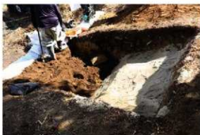
写真20 第11次調査の保護砂による埋め戻し
