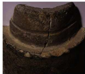
(細部) 玉縁凸面の水切り溝
