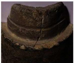
(細部) 玉縁凸面の水切り溝
