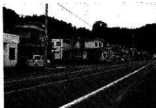
1. 調査前風景 (北東から)
