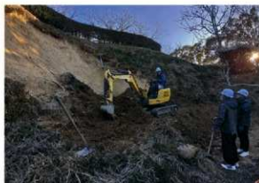
復旧工事の様子
