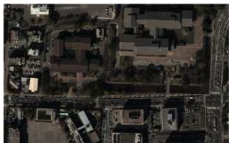
2019 年空撮 (右：旧検査庁庁舎、左：第 3 合同庁舎) 鹿児島城御校門再建前
