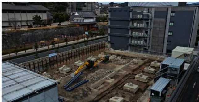
第2図 調査状況(左:鹿児島城御楼門(黎明館), 奥右:検察庁新庁舎(H29年調査区部分))
