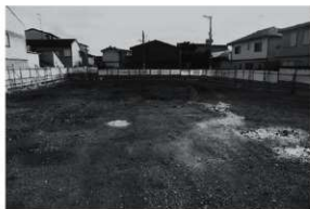
8. 調査完了後（北から）
