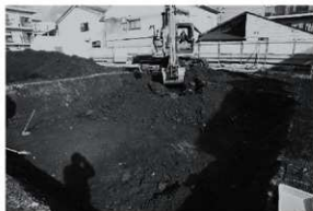
2. 重機掘削作業（南西から）
