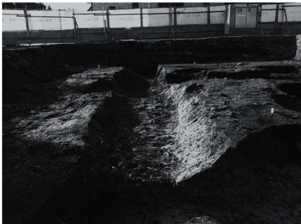
1. 溝13完掘状況（東から）
