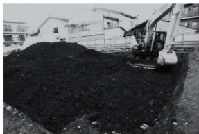
7. 埋め戻し作業（南西から）
