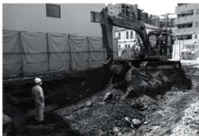
2. 重機掘削 (北東から)
