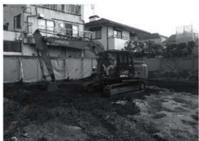
7. 埋め戻し作業（南西から）
