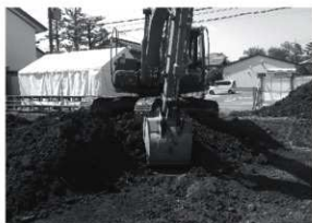
2. 重機掘削作業（北東から）
