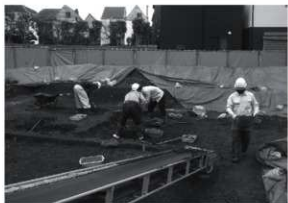
3. 層間掘削作業（南西から）
