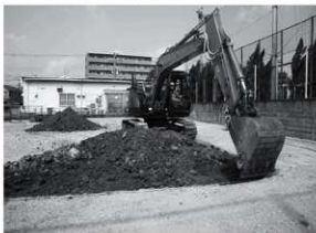
3. 重機振削作業
