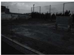
8. 埋戻し終了後（南東から）
