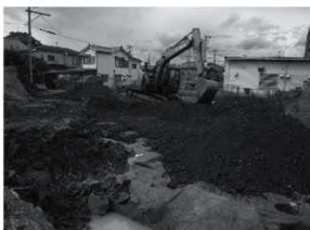
7. 重機による埋戻し作業
