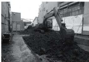
8. 調査完了後の埋戻作業（南から）
