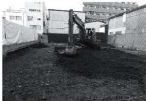
3. 重機による盛土掘削作業
