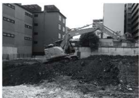
7. 南区埋め戻し作業（北から）
