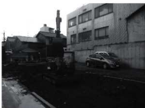
7. 埋戻しと転圧作業
