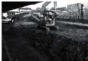
3. 重機掘削（南西から）
