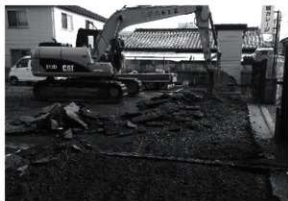
2. アスファルト撤去（西から）
