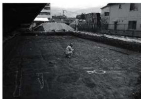
7. TS測量作業（南西から）
