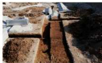
写真 19 SK19 (北西から)
