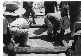
55SE1井戸枠組み立状況
