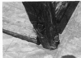
55SE1井戸枠組み立 (部分)
