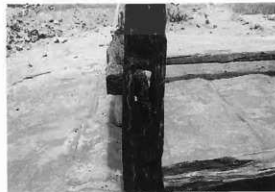
55SE1井戸枠組み立 (部分)
