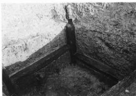
55SE1井戸枠部分
