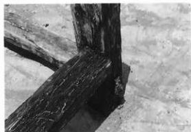
55SE1井戸枠組み立 (部分)
