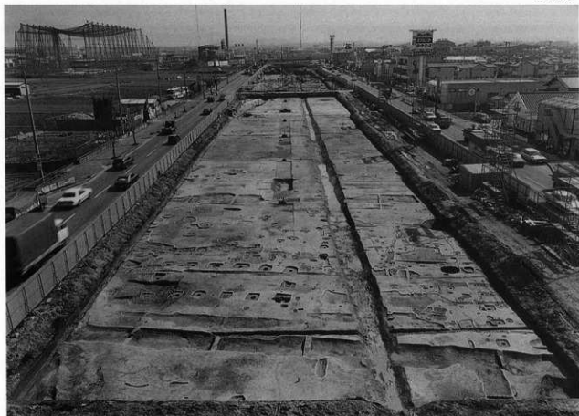
1. F地区全景（北から）
