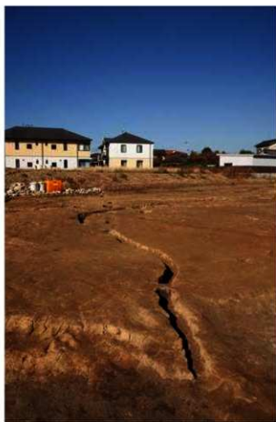
SD3 (南東から)
