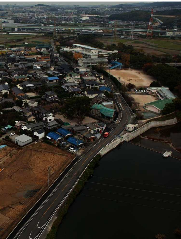
調査地全景と多々良川(南東から)
