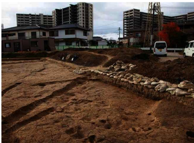
SX1 完成状況(北東から)
