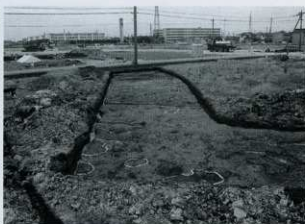
遺構検出状況 (南から)
