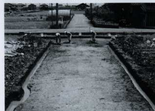
C-3区 作業風景
