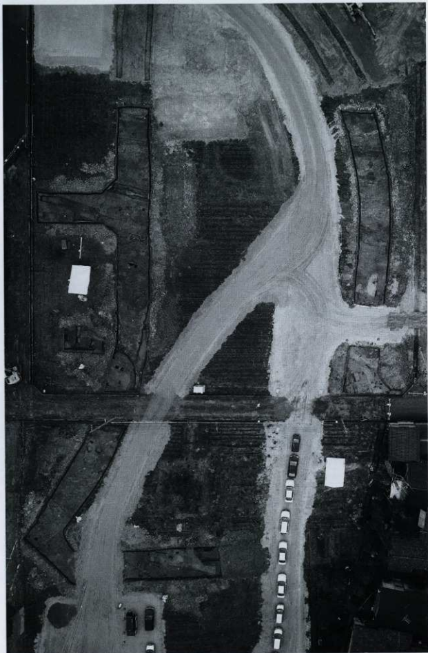
C-1・2区 全景写真
