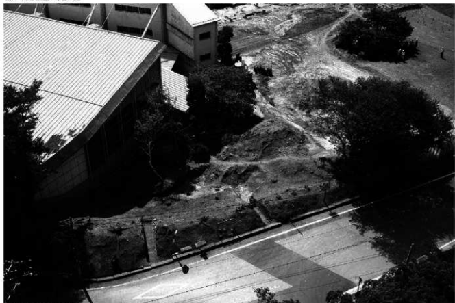
藤ヶ城跡土塁調査状況
