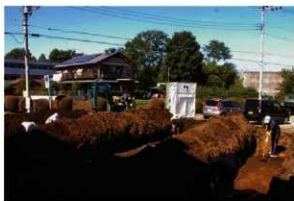
2. 確認調査風景
