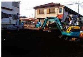
3. 表土剥ぎ作業風景
