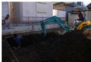
2. 表土剥ぎ作業風景
