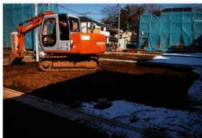
7. 第62㉡地点調査区近景
