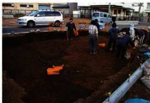
8. 第62㉡地点調査区整備風景
