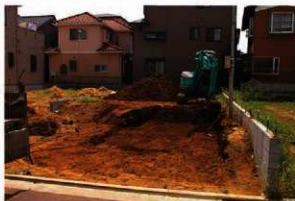
4. 第62㉠地点表土剥ぎ風景
