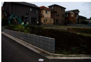
5. 第62⑥地点調査区近景
