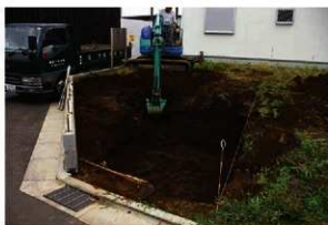
2. 第62①地点表土剥ぎ風景
