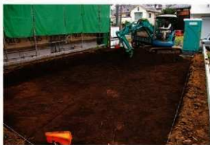
6. 第62㉠地点表土剥ぎ風景
