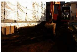
8. 第62⑦地点表土剥ぎ風景
