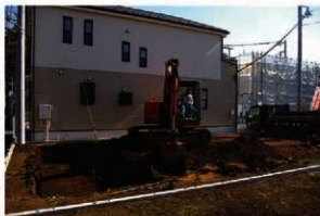
4. 第62③地点表土剥ぎ風景
