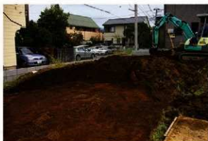
6. 第62⑥地点表土剥ぎ風景
