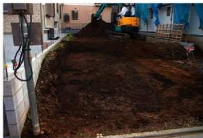
2. 第62㉠地点表土剥ぎ風景
