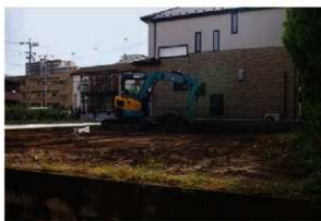
1. 表土剥ぎ風景
