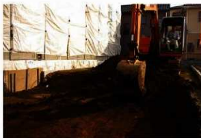
8. 第62⑦地点表土剥ぎ風景
