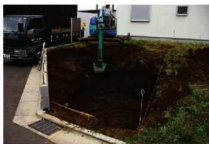
2. 第62①地点表土剥ぎ風景
