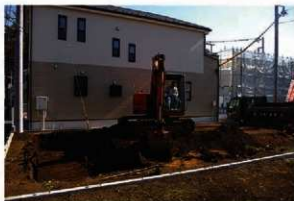
4. 第62③地点表土剥ぎ風景
