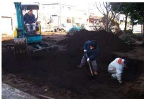
2. 表土剥ぎ風景
