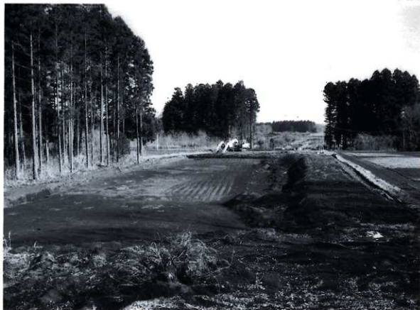
調査地区表土除去状況（西から）
