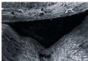
堀断面・B地点（北東から）
