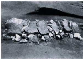
5号墳横穴式石室天井部 (南西から)
