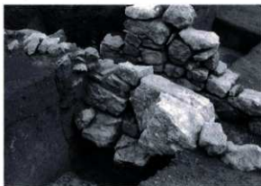
6号墳側壁裏込め断面 (南西から)
