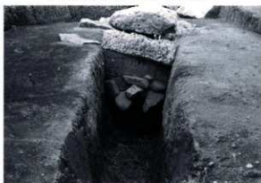
5号墳基道及び閉塞状況（南から）
