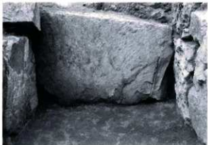
4号墳玄室奥壁（南から）
