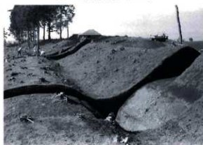
堀・土塁（東から）
