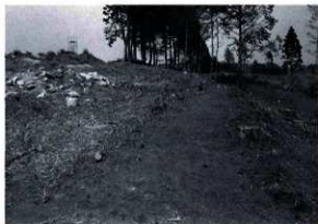
堀・土塁現況（南西から）
