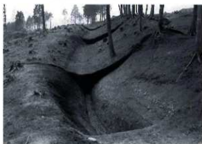
堀・土塁（北東から）
