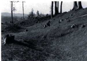
1号土橋現況（北東から）
