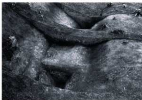
2号土橋（南西から）
