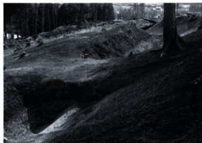
1号土橋と折部（北から）
