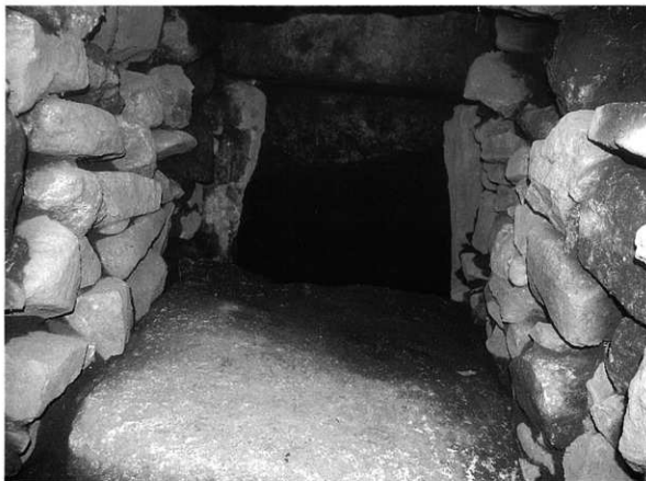
横穴式石室玄門付近（北から）
