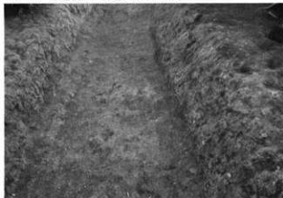
F. SD-1完掘(北より)
