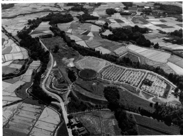
②道跡全景（南東上空から）
