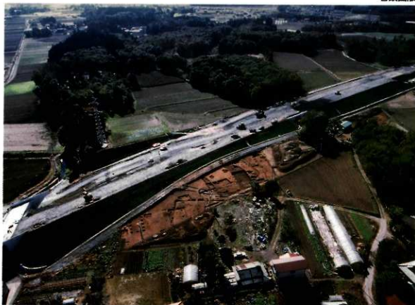
■上神主・茂原官衙遺跡全景（北上空から、手前が北関東自動車道側道調査区）
