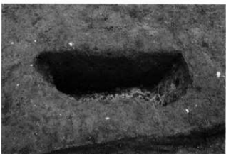
G. SB-1 · P-2 土層 (南より)
