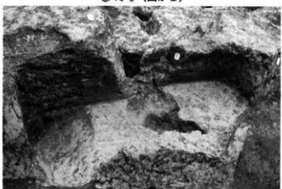
⑦46号完壁状況 (西から)
