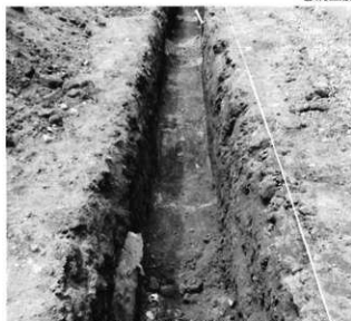
②T-1掘削状況 (北から)
