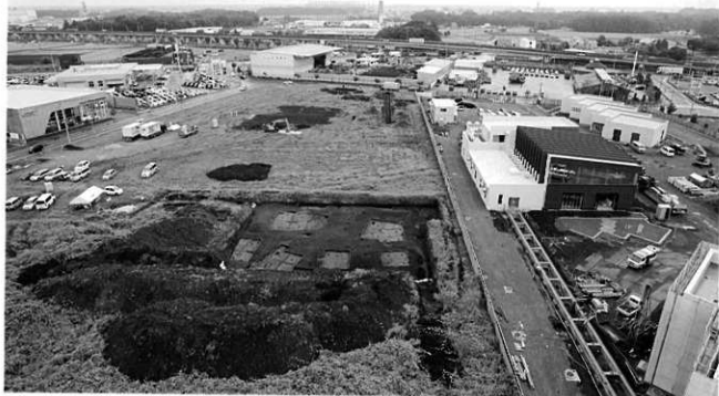
A. 調査区全景空中写真（手前G区、奥H区、西より）
