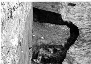
D. 同前近景（北より）
