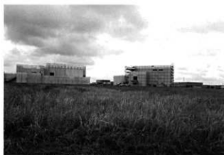
A. 調査前の状況（北東より）
