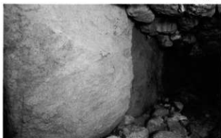
H. 同前天井石 (北下方より)
