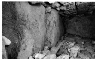
D. 同前天井石 (南下方より)
