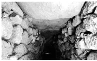
H. 同前天井石（北下方より）
