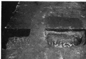
①25号・26号セクション (東より)
