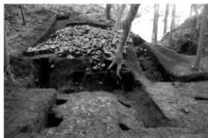
③T-10石積造構確認状況（北から）
