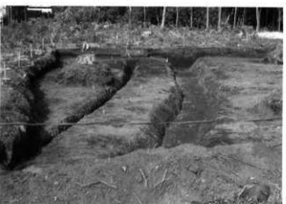
G. SD-1・2完掘 (南から)
