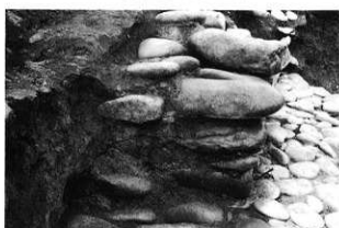
F22号墳石室側壁断面（北より）
