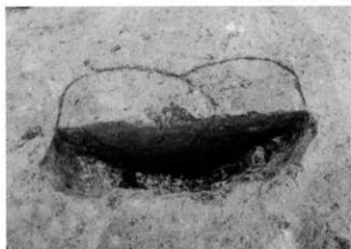
SB-2 PT-4 A・B(南より)
