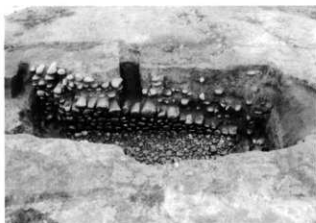
C. 18号墳石室側壁 (東より)
