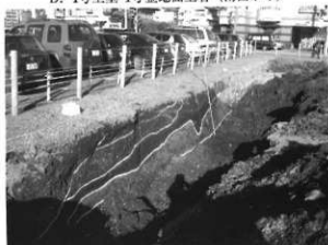
F. 2号整地面 (西側) 土層 (南西から)
