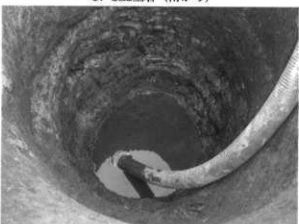
E. SE2底面状況 (南から)
